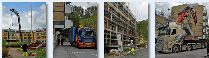
Bilder från pågående renovering
