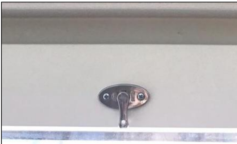
Läge då barnspärr är aktiverad och fönster endast öppnar ca. 10 cm.
