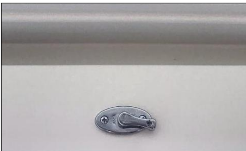
Läge då barnspärr ej är aktiverad och fönster öppnar fullt ut.
